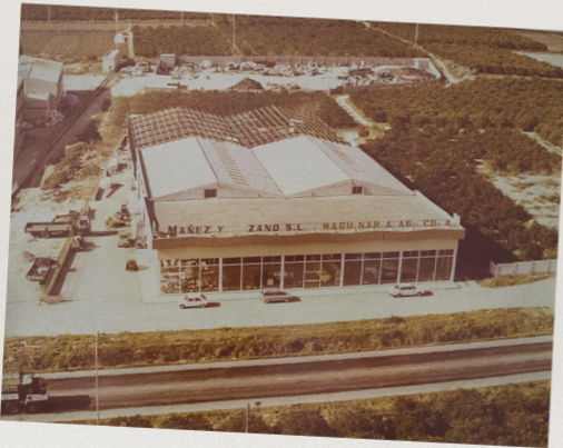
Construcción de la ampliación de la fábrica
