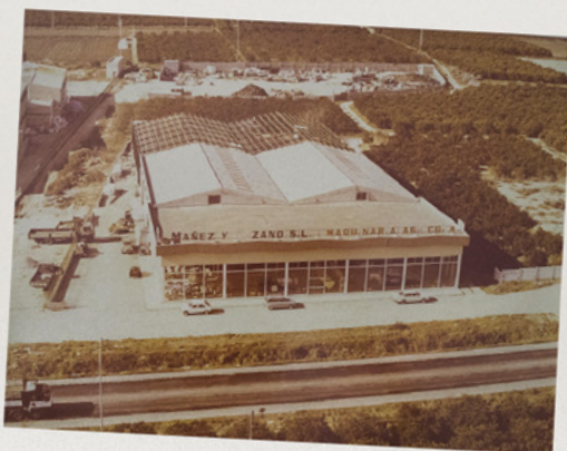
Construcción de la ampliación de la fábrica
