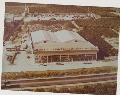
Construcción de la ampliación de la fábrica
